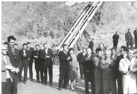
Закладка высотного здания КБРП на ул. Героев Панфиловцев, 10, 1966 г.
